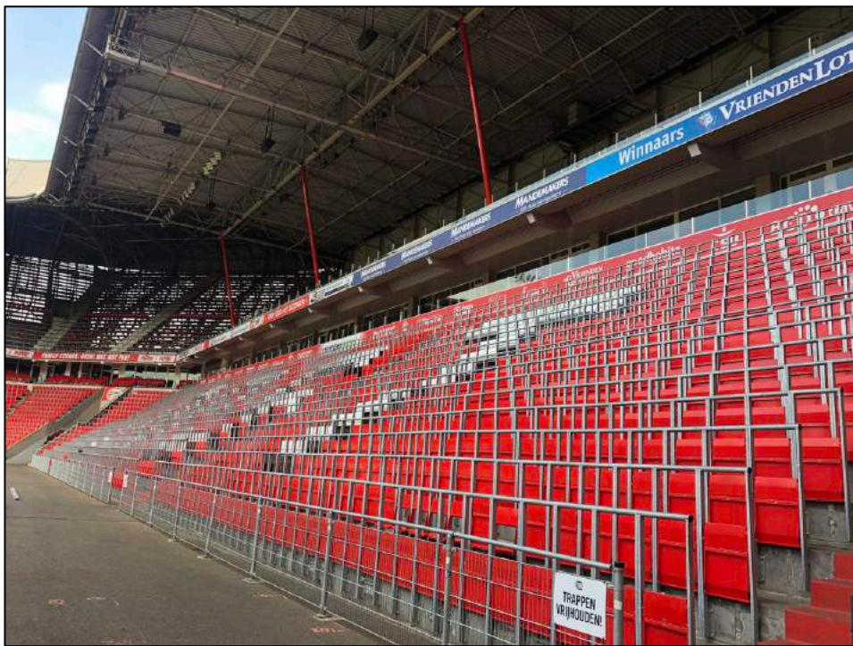
Safe standing tribune PSV Eindhoven (De gehele sector "Oost-onder" betreft Safe standing)
